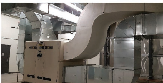
เครื่องดูดความชื้นที่ใช้สารดูดความชื้น
